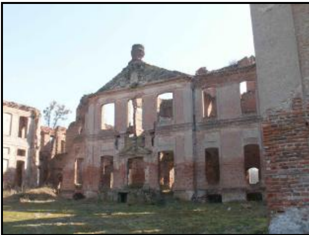
Fot. 25. Kamieniec, ruiny pałacu
