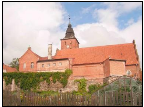
Fot. 30. Susz, mury obronne
