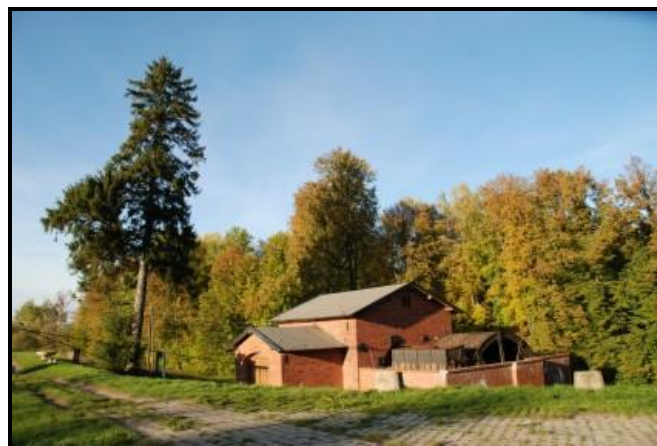
Fot. 18. Maszynownia przy pochylni Kąty
