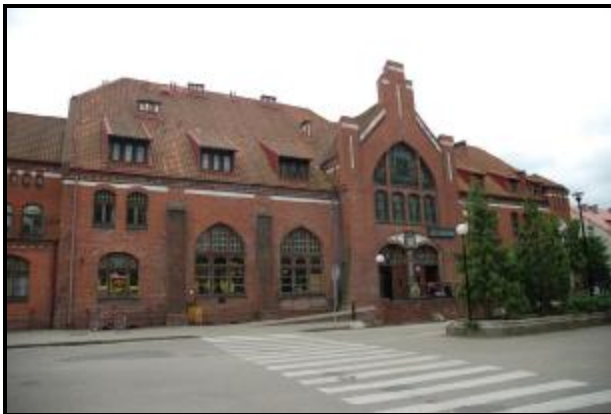
Fot. 31. Iława – budynek dworca
