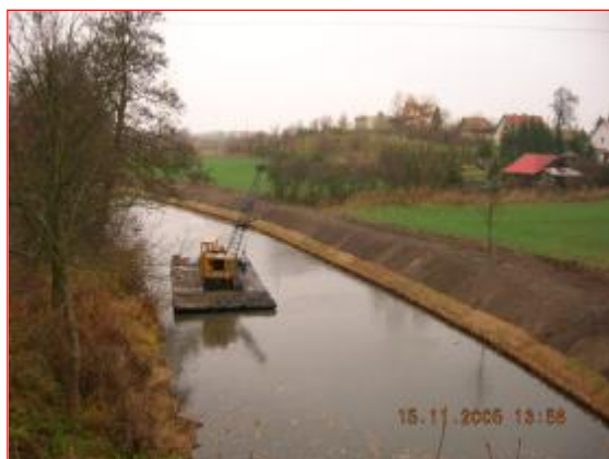
Widok umocnionego i oczyszczonego z krzewów, trzciny i chwastów kanału
